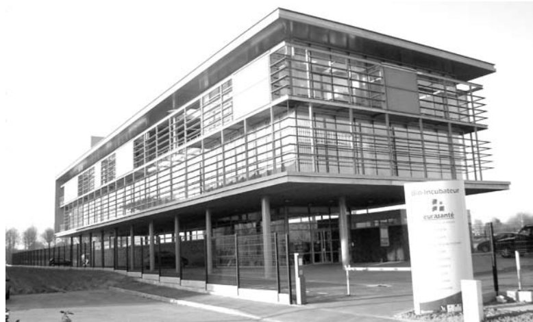
Bio-incubateur Eurasanté qui accueille, sur le Parc Eurasanté, de jeunes entreprises innovantes dans le secteur de la Biologie Santé. Les sociétés MVE Innovations et Ethilog y sont notamment installées.
